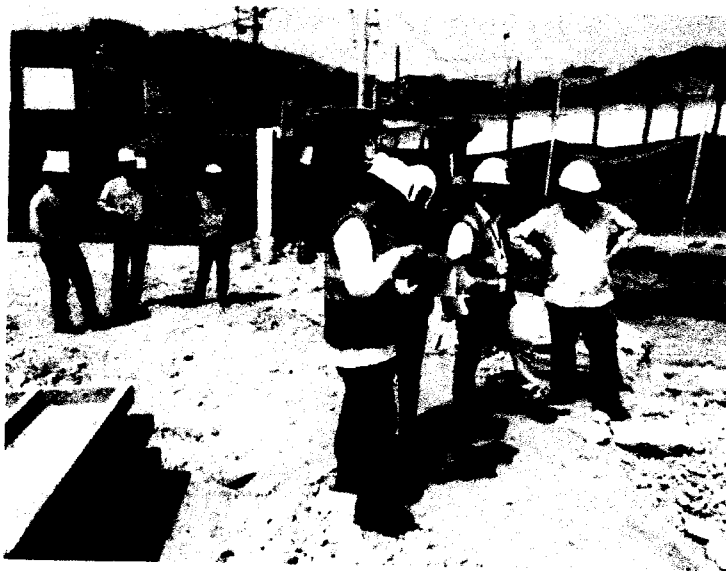
Foto 33: Inspección de Obra por los señores de la Sunafil
