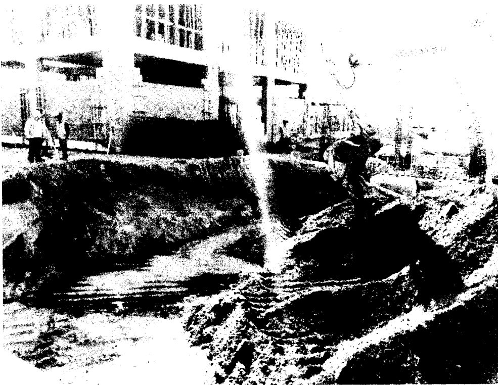
Foto N° 03: Excavación masiva, la cual será cobrado por mayor metrado.
